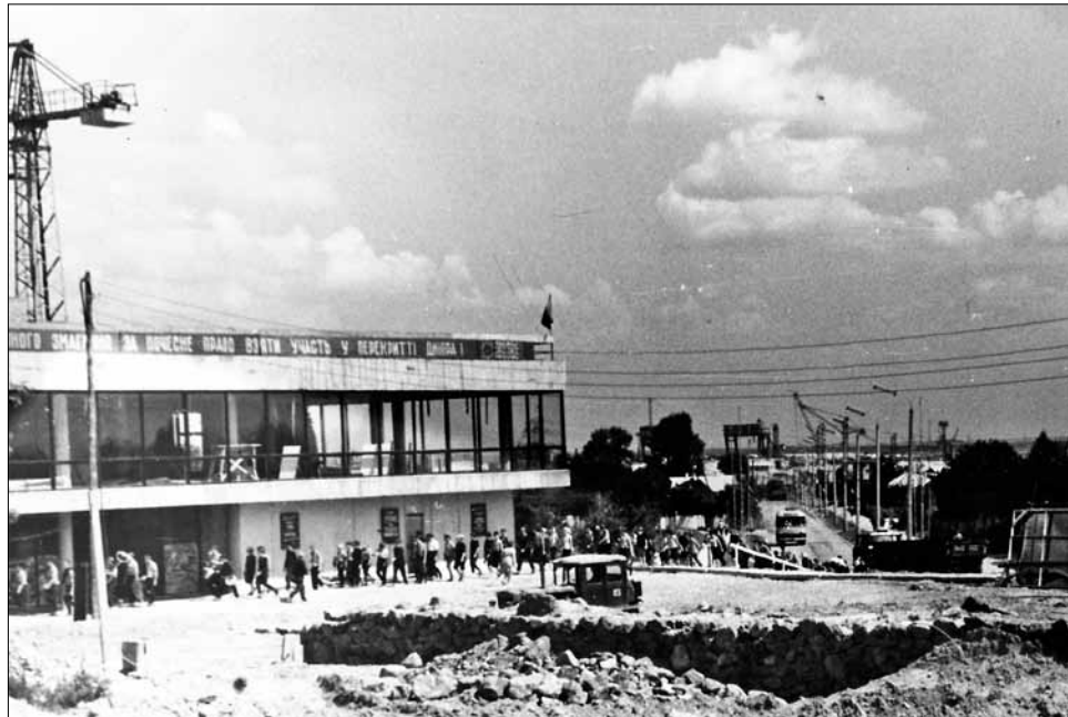
Іде будівництво «Енергетика», 1961-1962 роки.
